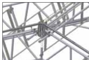
Monteret faldsikringsbeslag
