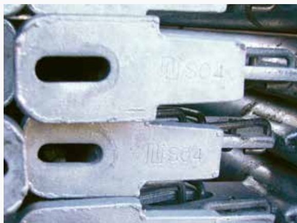
Eksempel på merking av bjelke eller rekkverk i høyholdfast stål.
